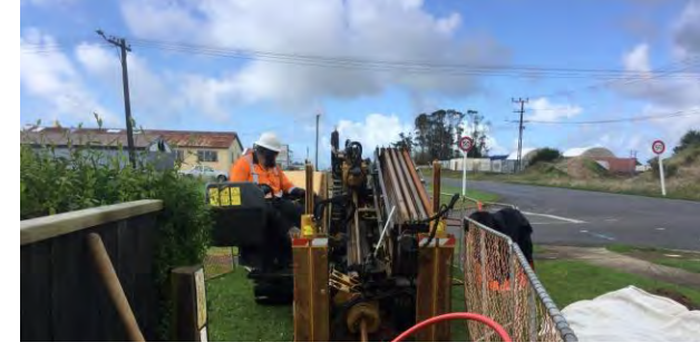
Perforación Direccional Horizontal
